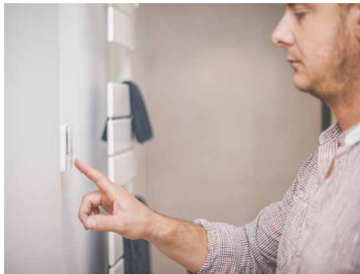
Im Badezimmer installierte Timo Beier Wiser gleich doppelt – das System ist mit dem Handtuchhalter und der Fußbodenheizung verknüpft.
