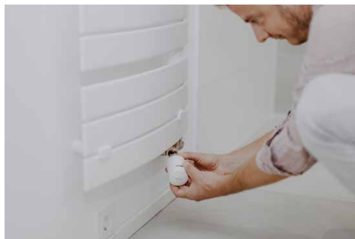
Einfache Anbringung und zügige Installation waren der Familie besonders wichtig.
